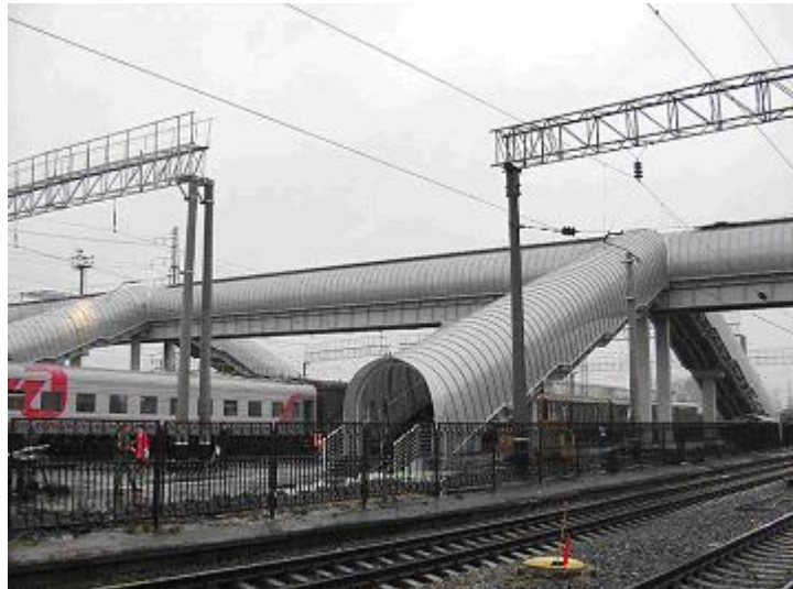
Рис.1. Пешеходный мост через железнодорожные пути
